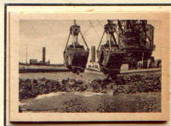
49. Dichting van het sluitgat, 28 Mei 1932, 13.02 uur
